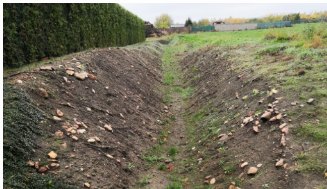
Foto č. 5 a 6 – ukázka příkopů k odvedení povrchové vody přitékající z pole. Podporuje erozi a povodňové průtoky. Mnohem vhodnější je zemní val, za kterým voda vsákne a orná půda není navždy odnesena do vodních toků a nádrží.
