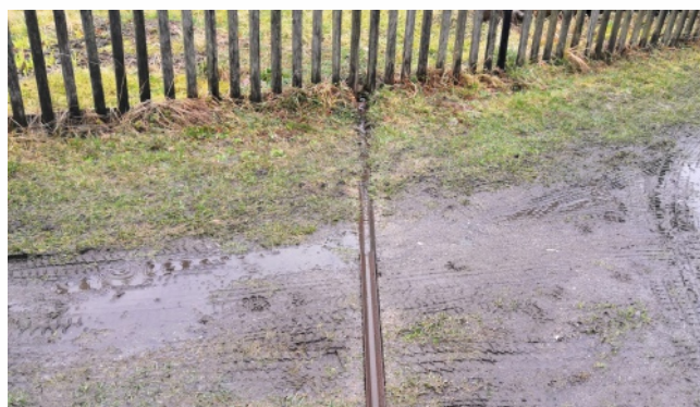
Foto č. 3 a 4 – ukázka odvedení dešťové vody ze střechy a její následné zasakování na travnaté ploše.
