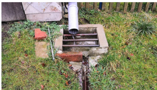
Foto č. 3 a 4 – ukázka odvedení dešťové vody ze střechy a její následné zasakování na travnaté ploše.
