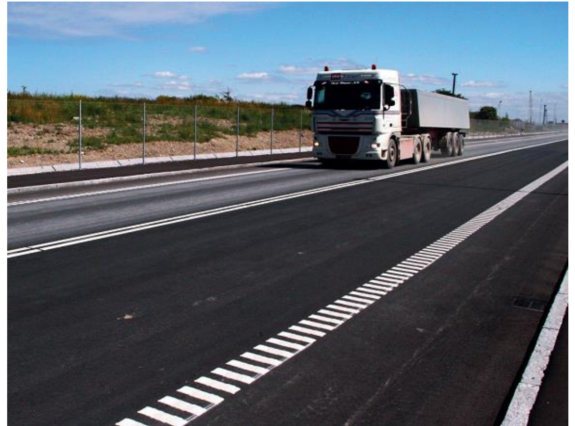
Podkladová vrstva pod silnicí, rozšiřování přístavu v Kodani
