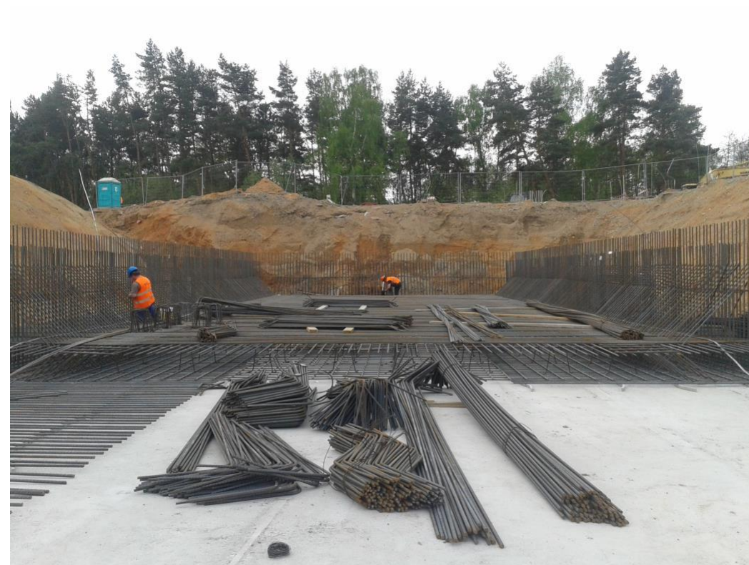
Montáž armatury bunkru na SKO
