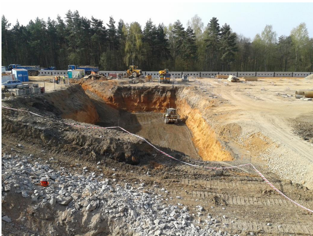
Zemní práce na objektu SO-01-Bunkr na SKO
