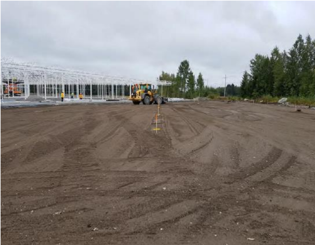
Podkladová vrstva pod skleníkem pro pěstování okurek, 20 tis. t, Finsko, 2018
