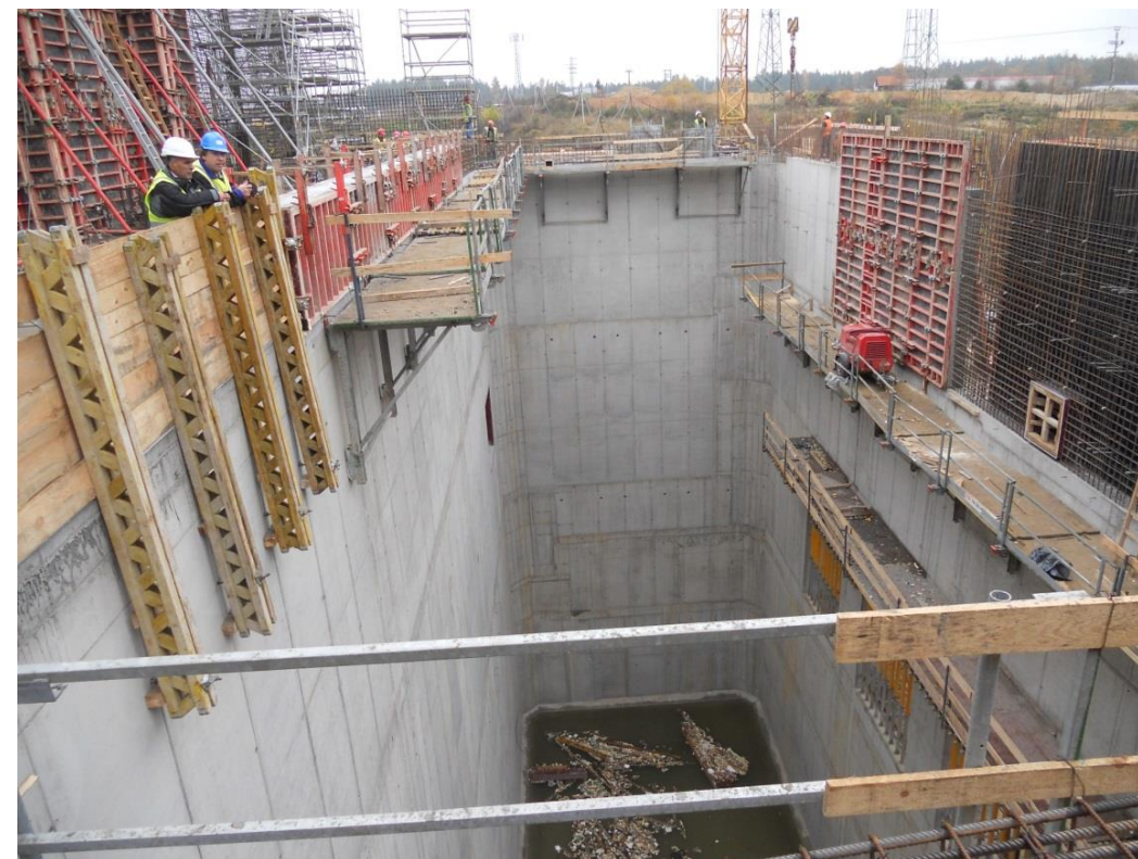
Pohled do prostoru pro uložení komunálního odpadu v objektu SO 01 Bunkr na SKO
